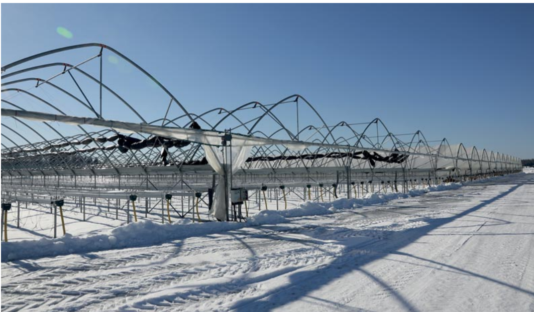
Kasvutunneleissa viljellään sekä vadelmaa että mansikkaa. Muovilla katetut tunnelit on varustettu kastelujärjestelmillä.
