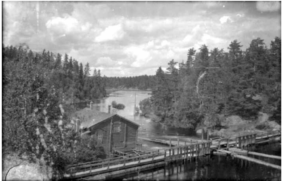
Patosilta Jokelan Myllynkoskessa. Koskessa on ollut mylly ja patorakenteet pitkään. Tulvat ovat niitä vaurioittaneet useasti. Uiton aikaan oli käytössä tukkien uittoränni, joka näkyy kuvan keskellä. Jauhatuksen loputtua 1950 luvulla ja uiton päätyttyä 1960 luvulla rakenteiden kunto rapistui. Mylly kunnostettiin 1998 nykyiseen asuun ja patorakenteet purettiin uuden pohjapadon tieltä 1999. Viimeisenä rakennettiin nykyinen ulkoilusilta kosken yli.
