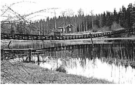
Käyrälammesta alaspäin n. 300 m oli 1947 pioneerien rakentama 82 metriä pitkä silta. Sitä käyttivät mm. uittomiehet, lähes 20 mökin asukkaat, retkeilijät, suunnistajat ja puolustusvoimat harjoituksissaan. Silta purettiin huonokuntoisena 1981.
