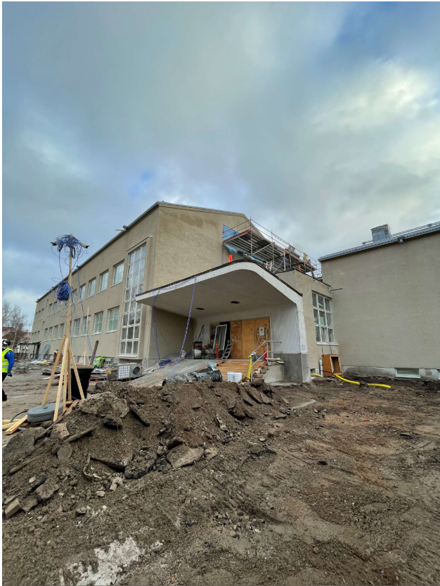
Keskuskoulun peruskorjaus valmistumassa 06/2025
