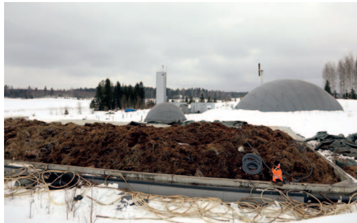
Etualalla on luomubiokaasulaitoksen biokaasureaktori. Harmaat kuvut ovat kaasuvärisäiliöt.
