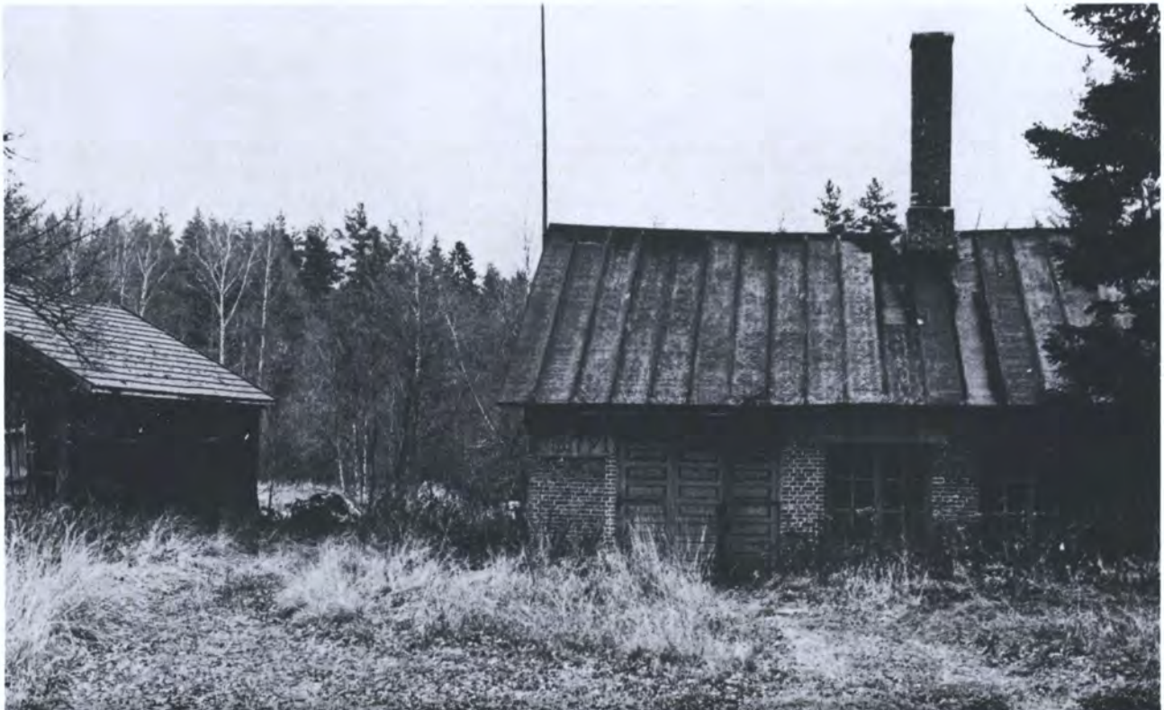
B.M. Björkmanin rakennuttama kankipaja ja varasto 1790—91. KL
