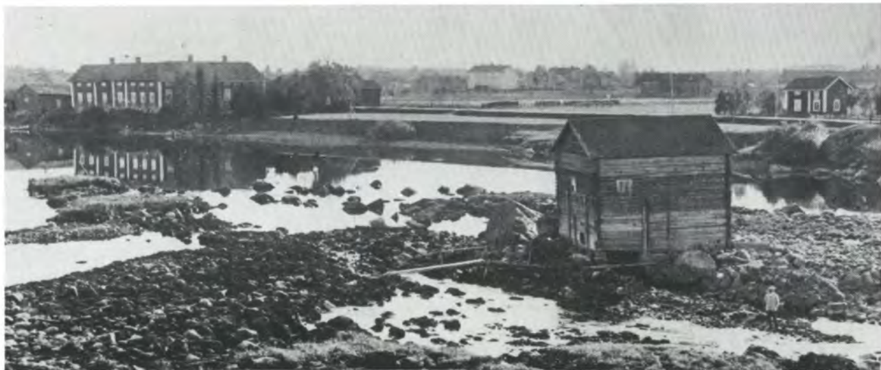
Reinilänkoski n. 1905. Vasemmalla Knaapila, jota vastapäätä joen toisella rannalla on Varpola. Kerrotaan, että Kalke nuukana miehenä olisi vaatinut Knaapi-paapalta vuokraa siitä, että tämä katsoi tuulensuuntia Kalken tuuliviiristä joen yli.
