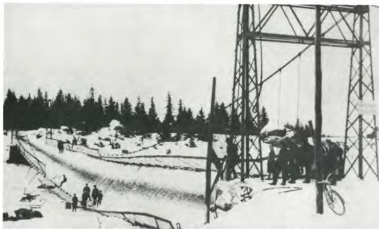
Perttilän riippusilta, tehty v. 1909, putosi Kalken jyväkuormien alla v. 1916. Tapaus oli niin huomattava, että siitä kirjoitettiin kertova runo. Sillan päissä oli varoitukset: "Juosten ajo kielletty". Kuva Eila Tuomisen kuvastosta.
