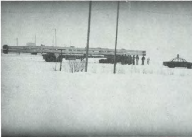
Uutta siltaa suunniteltiin pitkään, monia vaihtoehtoja selvitettiin, piirustuksia ja kustannusarvioita laadittiin. Lopuksi ostettiin TVL:ltä Yli-Iistä 60 m pitkä, yli 100 tn painava teräsristikkosilta, joka siellä purettiin ja kuljetettiin osina Valtaalaan 13. 4. 1977.
