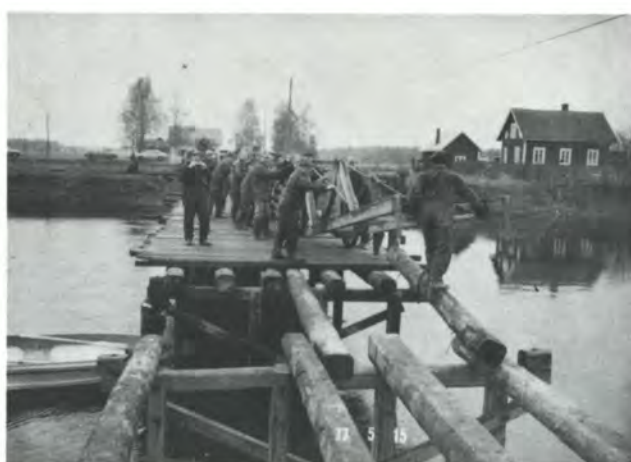
Sillan niskat ja välipukit siirretään rannalle miesvoimin liikuteltavan purku- ja kokoamiskärryn avulla.
