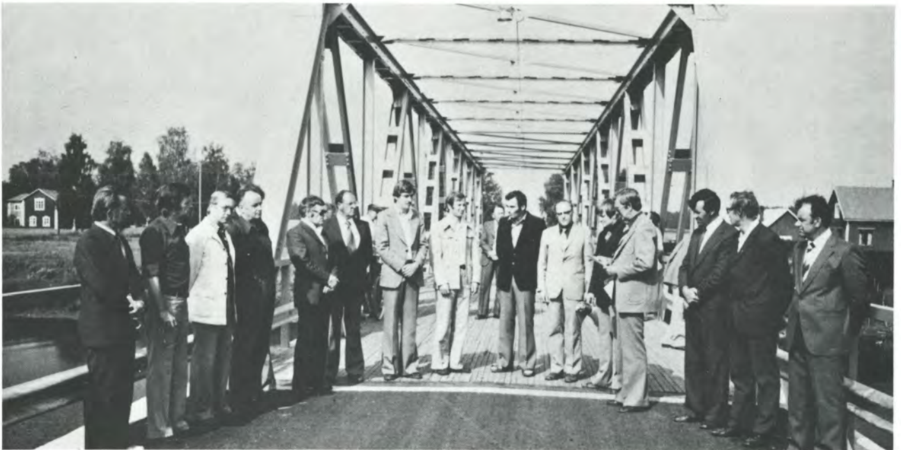
Kansi, kaiteet, valot ja muut rakennelmat ovat valmiit. Sillan luovutus-vastaanottotilaisuuden väkeä 3. 8. 1978.
