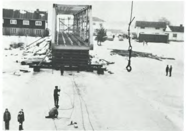
Kyrönjoen jää oli jäädyttämällä vahvistettu lopullista paikallensiirtoa varten, siirto tapahtui 1. 3. 1978. Sillan siirrot olivat todellista kansanjuhlaa!
