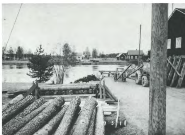
Kohonnut vesi peitti alapukit ja näin liikkuvat jäät eivät päässeet niitä vahingoittamaan. Vuosittain jouduttiin varsinkin sillan niskoja uusimaan. Kokoaminen tapahtui heti, kun vedenpinta vähän laski ja virtaaminen hidastui. Silta saattoi olla purettuna 1–3 viikkoa. Parina keväänä siltaa ei tarvinnut purkaa lainkaan, jäät menivät niin hajonneina, että silta kesti niiden töyssäykset.
