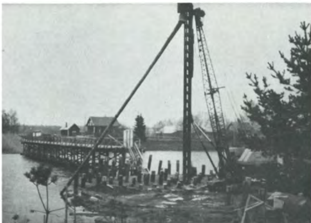
Koska sillan pituus ei riittänyt joen yli, haettiin vesioikeudelta lupa kaventaa joen uomaa rakentamalla Valtaalan puolelle tietä. Paalujen junttaminen käynnissä 1. 11. 1977. Paalujen pituudet olivat 9—15 m.
