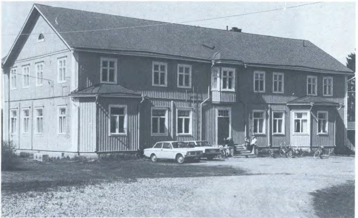
Vanhukset pääsivät muuttamaan rakennusaikaisesta asunnostaan, vanhalta yhteiskoululta, uusiin ajanmukaisiin tiloihin joulukuun alkupäivinä.
