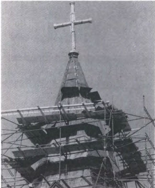
□ Kohta katon tekijät ovat päässeet ristintuntumaan ja rakennustelineet kohoavat samaa tahtia. Ristinkin joutui samalla kertaa uusittavaksi ja tehtiin kyllästetystä puusta, joka kestää muutaman sukupolven ajan.
