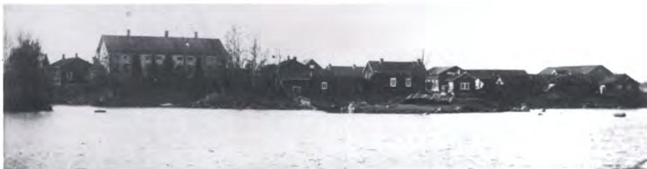
2. Isonkyrön kirkkoherran pappila. Kuva on vuodelta 1905. Vasemmalta: Pitäjätupa, joka on siirretty v. 1927 Vanhan kirkon lähelle seurakuntataloksi. Talo on kunnostettu 1987 kerhotuvaksi. Pappila vuodelta 1848, talousrakennuksia. Pitkin jokeen oleva kaksi-ikkunainen rakennus on renkitupa. Sen päädyttä oli talvitie joelle. Oikealla navetta, harja ylimpänä.
