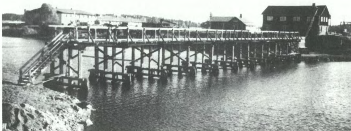
Ylipään teräsristikkosillan maisemaa vuonna 1977. Akkaansilta on rannoilta purettu uuden sillan perustöiden takia. Kujalan rakennukset ovat vielä paikallaan. Johan-Puun tehdas hallitsee nykyisin maisemaa. Kuva Matti Loukola.
