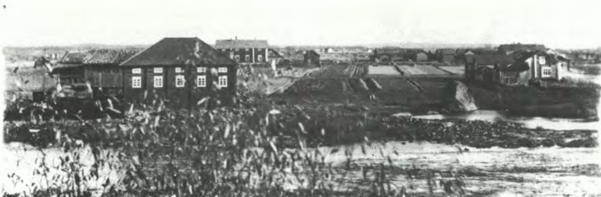
Reinilänkosken sillan paikka v.1905. Vasemmalla Reinilän mylly, jonka paikalla on nykyisin Mäkysen talo. Merenranta oli näillä paikoilla Kristuksen syntymän aikoihin. Kuva Kustaa Levy.
