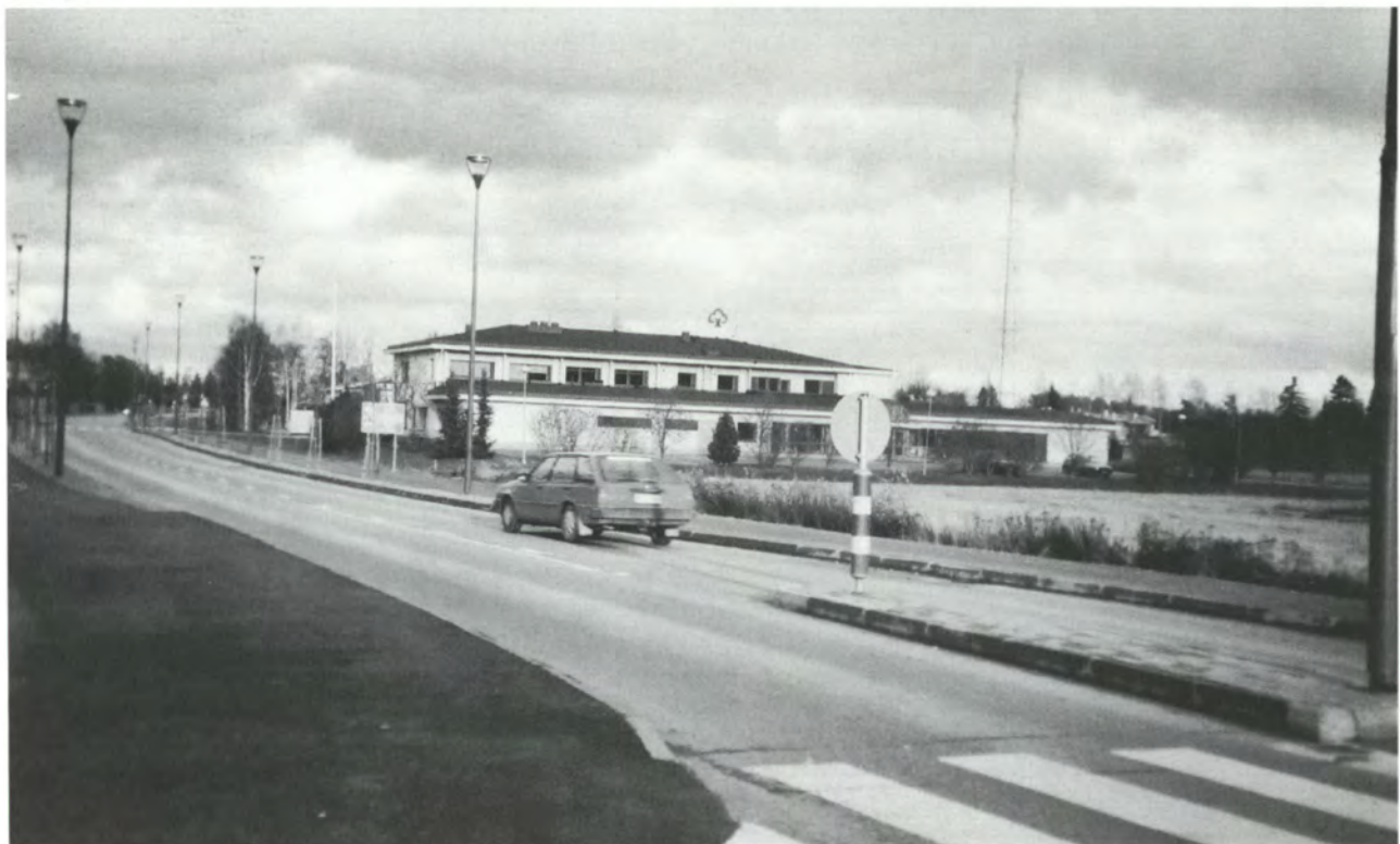
Isonkyrön keskusta koki liikenteellisen muodonmuutoksen. Tiet kapenivat 9 :stä 7 metriin. Jalkakäytäviä korotettiin ja muotoiltiin uudelleen. Tarkoituksena on tehdä keskusta jalankulkijoille turvallisemmaksi. Pyörätie jatkuu nyt valtatielle saakka. Uudet katulamput ja vielä hennot vaahteran ja koivun taimet somistavat päätietä.
