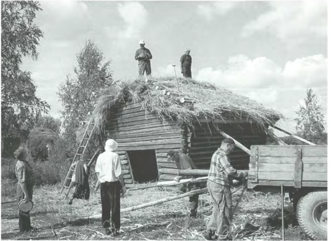
Museoalueen harmaahirsinen heinälato sai uuden olkikatteen kökkävään toimesta. Kuva Katri Kempainen
