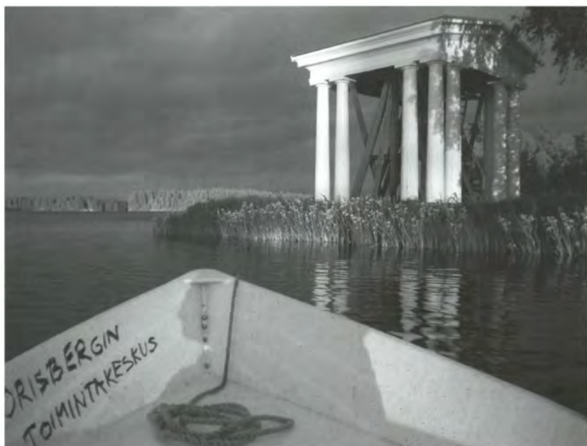
Kokka kohti kesää. Kellotapulin lattia korjattiin perusteellisesti ja lahot laudat ja lankut uusittiin. Ensi kesänä pylväät viimeistellään ja maalataan. Kiitos talkoomiesten, jotka uhrasivat aikaansa tähän kunnostustyöhön.
